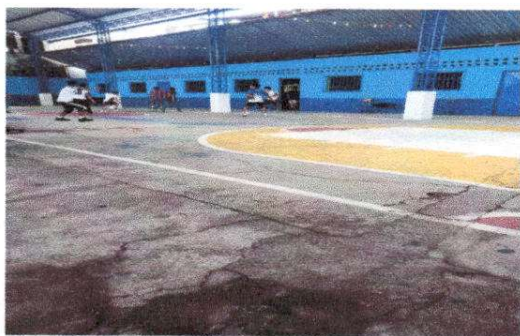
Foto 5: Sustrucción de piso de torta de concreto
