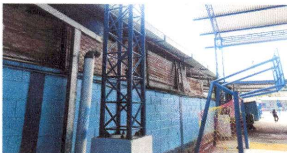
Foto 3: Reparación de tubo hg y malla galvanizada
