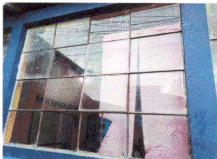
Foto 1: Sustrucción de estructura de metal de ventana
