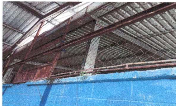
Foto 4: Reparación de tubo hg y malla galvanizada
